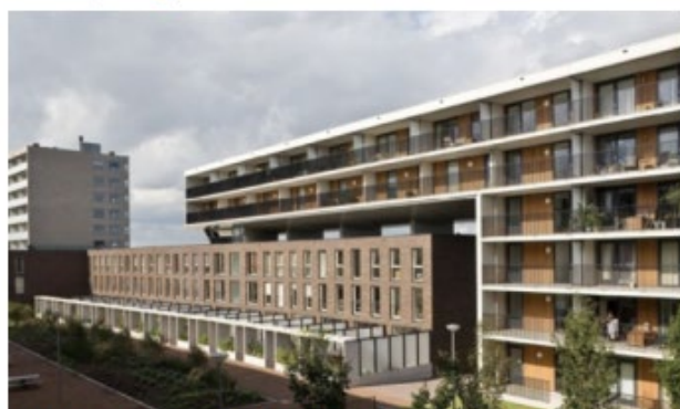
Appartementen boven grondgebonden woningen met een stadstuin op IJburg. Twee typologieën met het ruimtebeslag van één
